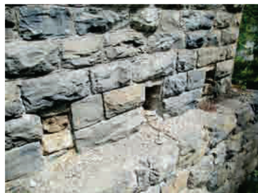
Abb.9: Solis Viadukt, Kämpfer, mit Resten des hölzernen Lehrgerüsts
